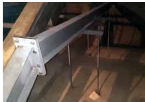
Mittels Stahlträger wurde das Gewölbe von oben stabilisiert.
