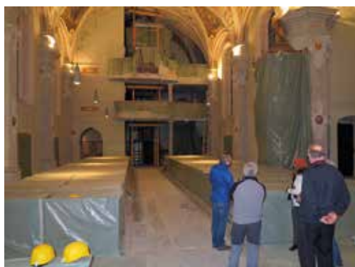
Zum Start der Arbeiten wurde im Rahmen einer Begehung die weiteren Schritte besprochen.
