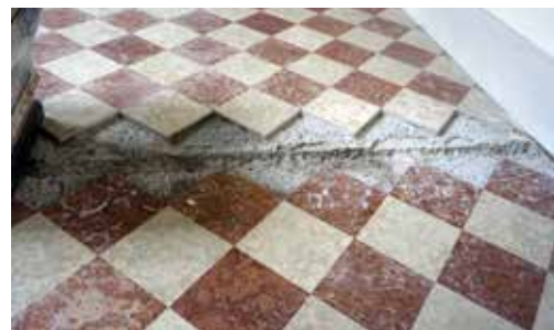
Für die Kabelverlegung im Boden mussten Marmorfliesen entfernt werden
